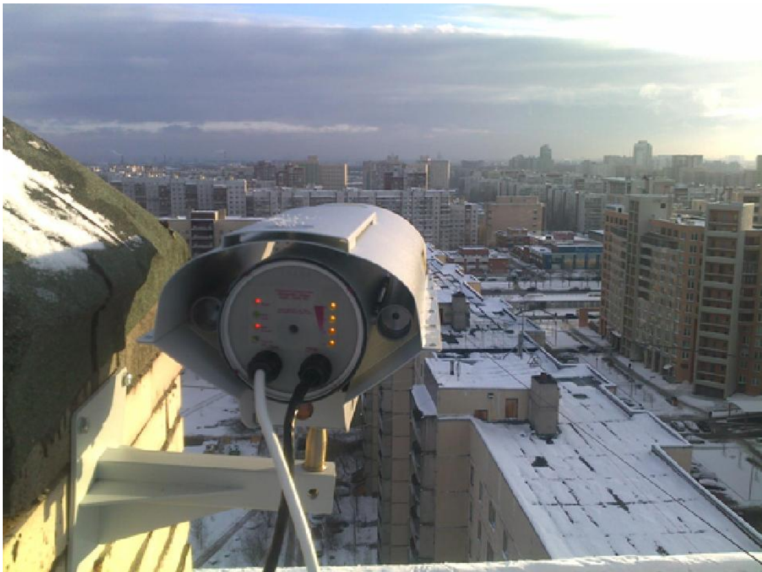
Поскольку опыта наведения подобного оборудования у нас не было, мы самостоятельно подготовили только места установки, протянули линии питания и Ethernet и установили кронштейны, согласно
