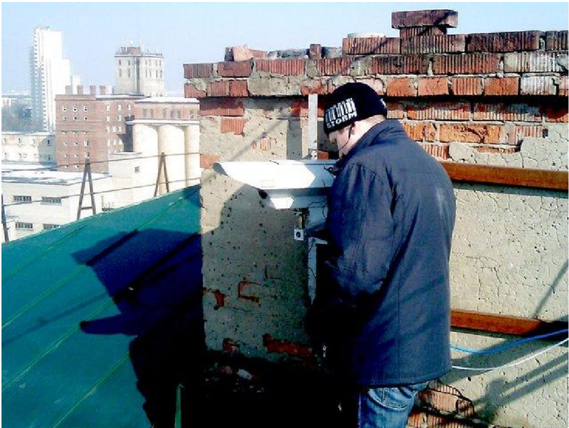
Второе место установки пришлось на стену последнего этажа 17-этажного панельного здания.
